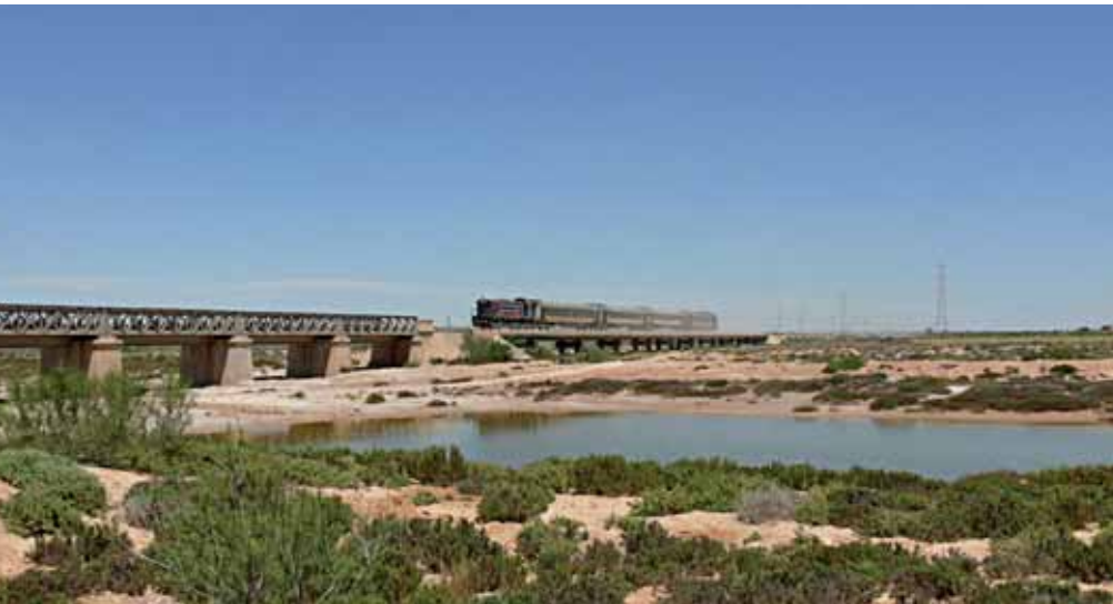
Die Brücken sind charakteristisch für die Küstenbahn.
